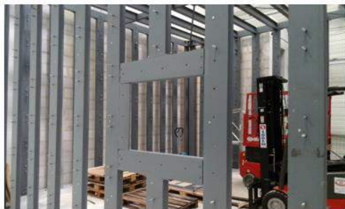
a- Struture métallique
