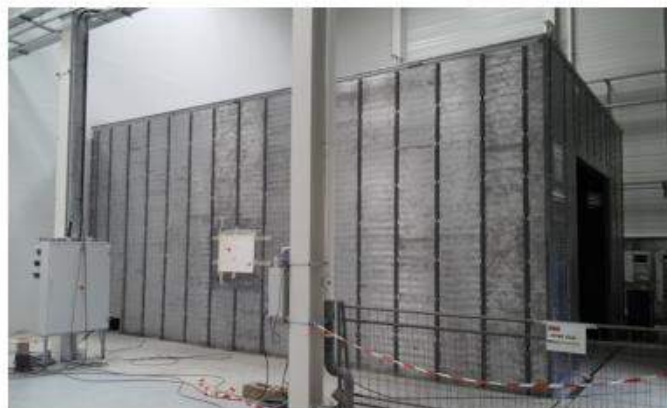
d- Structure métallique + parois en plomb
